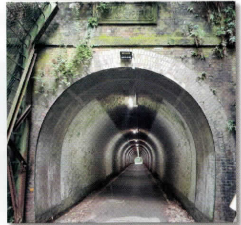
岩井寺隧道 長さ137m、幅員4m
