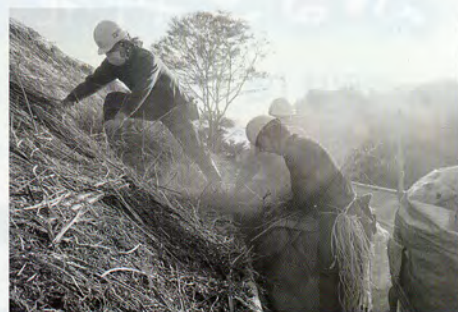
藁ぶき屋根解体
